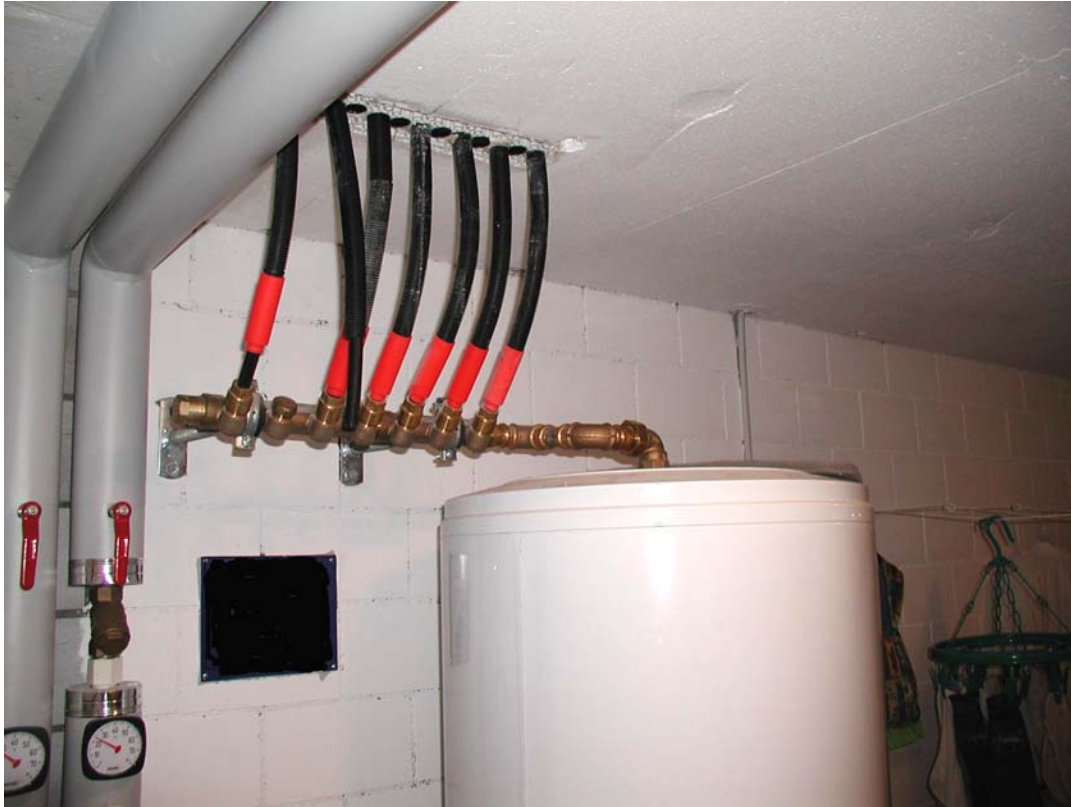
Foto 9: Schlechter Warmwasserverteiler und Speicheranschluss
