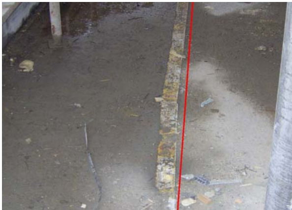
Foto 5: Verworfenener Kragplattenanschluss
