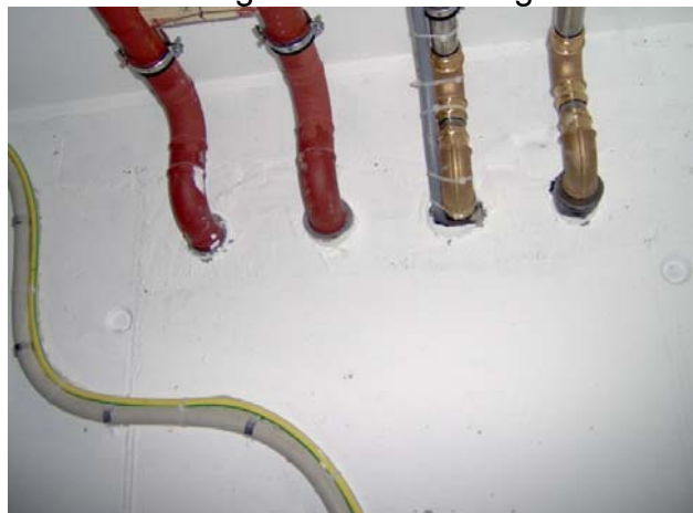
Mangelhafte Dämmung
