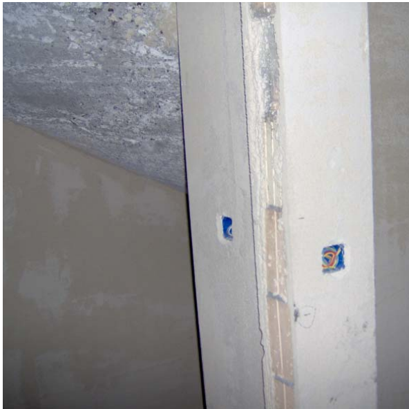
Foto 2: Wände zu unbeheiztem Untergeschoss
