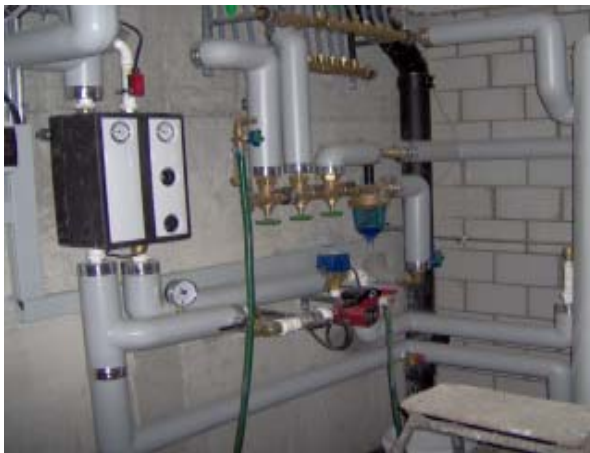
Foto 7: Witterungsgeführte Regelung an Stelle Einzelraumregelung
