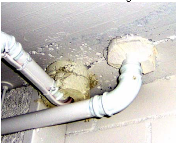
Foto 8: Isolationen bei Rohrdurchführungen
