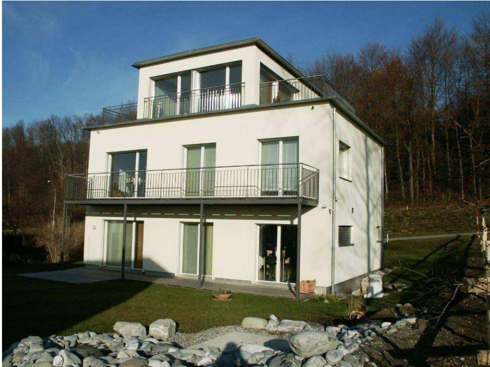
Das Untergeschoss des Gebäudes ist nicht beheizt. Der Dämmperimeter liegt an der Decke des UG's. Tragkonstruktion, Decken, Aussenwände und auch Innenwände bestehen aus Leichtbaukonstruktion in Holzbauweise. Das Gebäude ist aussen verputzt.
