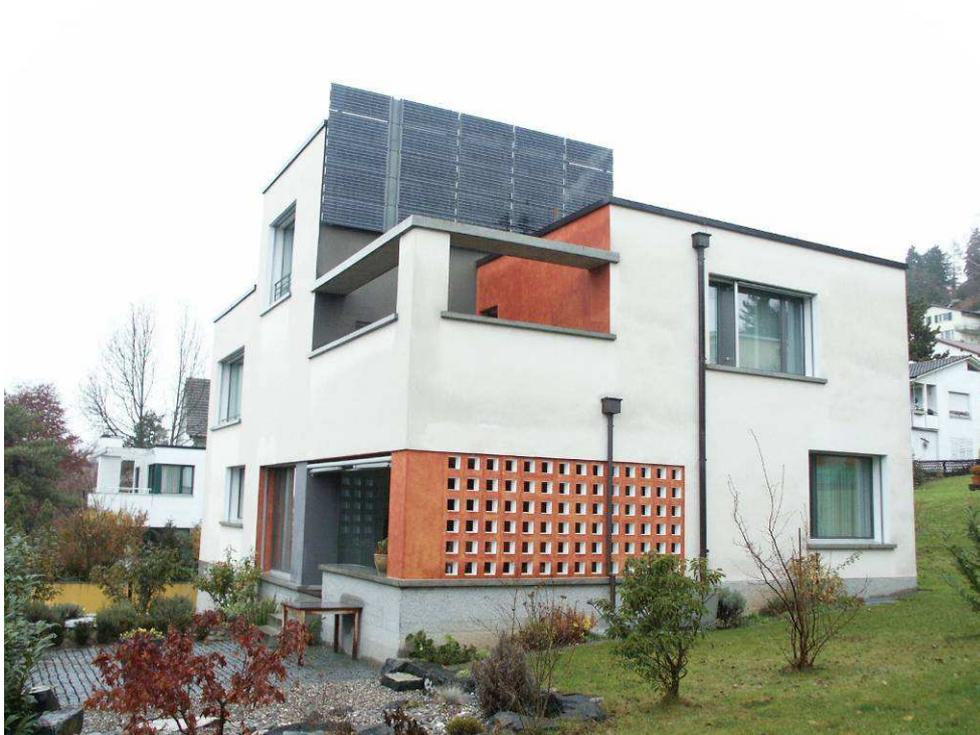
Die Aussenwände sind aus wärmedämmenden Backsteinen mit einem U-Wert von 0.21 gemäss Katalogangabe erstellt. Der Keller ist mit Ausnahme des Bastelraumes nicht beheizt.
