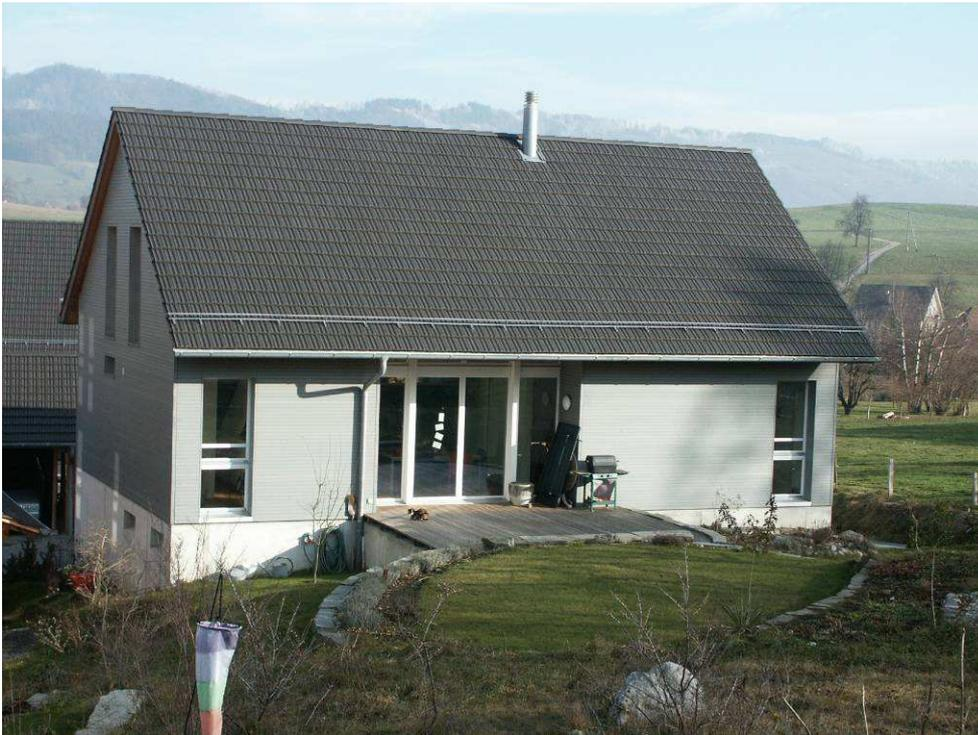
Das Gebäude ist Bestandteil einer grösseren Minergie Siedlung, steht aber frei. Aussenwände, Decken und Dach bestehen aus Leichtbauelementen in Holzbauweise. Im Untergeschoss liegt nur der eigentliche Lagerkeller ausserhalb des Dämmperimeters.
