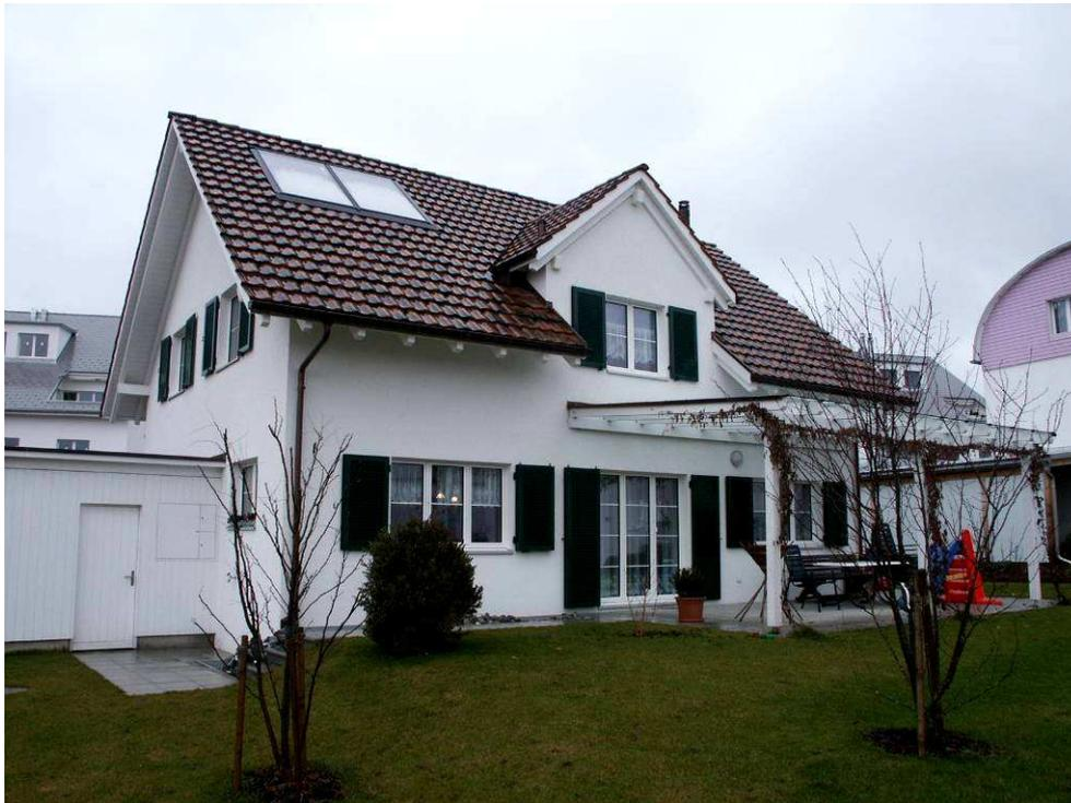
Das Gebäude besteht aus einer aussen verputzten Leichtbaukonstruktion in Holzbauweise mit ziegelgedecktem Holzsteildach. Der Kellerabgang mit Vorplatz liegt im Dämmperimeter. Der Ausbau im unbeheizten Kehlboden ist noch nicht fertig gestellt.
