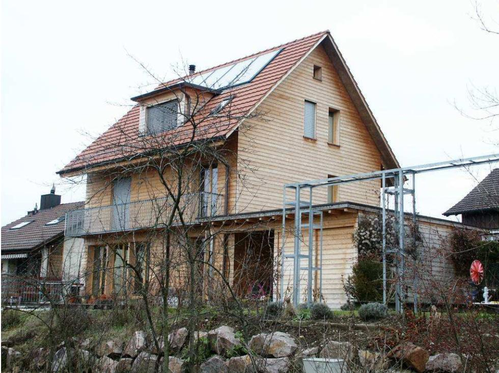
Das Gebäude ist Bestandteil einer Überbauung aus 3 Einfamilienhäusern und wurde in Holzelementbauweise erstellt. Der Keller ist nicht beheizt, der Wärmedämmperimeter verläuft über die Kellerdecke.
