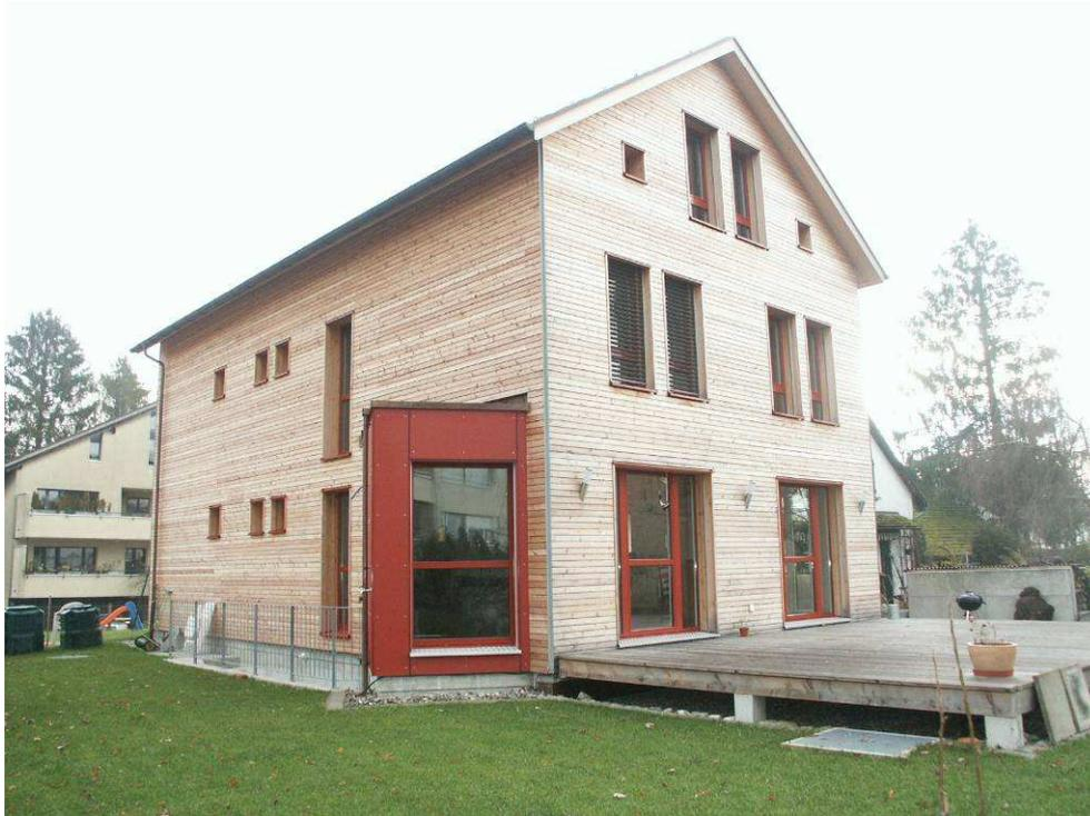
Das Gebäude besteht aus einer Holz-Leichtbaukonstruktion mit Holzbekleidung aussen. Der Keller ist nicht beheizt. Das Dach ist bis unter den Giebel genutzt. Erdgeschoss und Obergeschoss sind durch Lufträume miteinander verbunden. Manchmal werden ungemütliche Luftzugerscheinungen verspürt.
