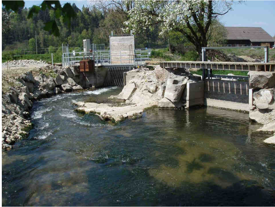
Fig. 9: Wasserwirbelkraftwerk Schöffland mit abgesunkenem Oberwasserspiegel (ungenügendes Reguliervermögen des Frequenzumrichters)
