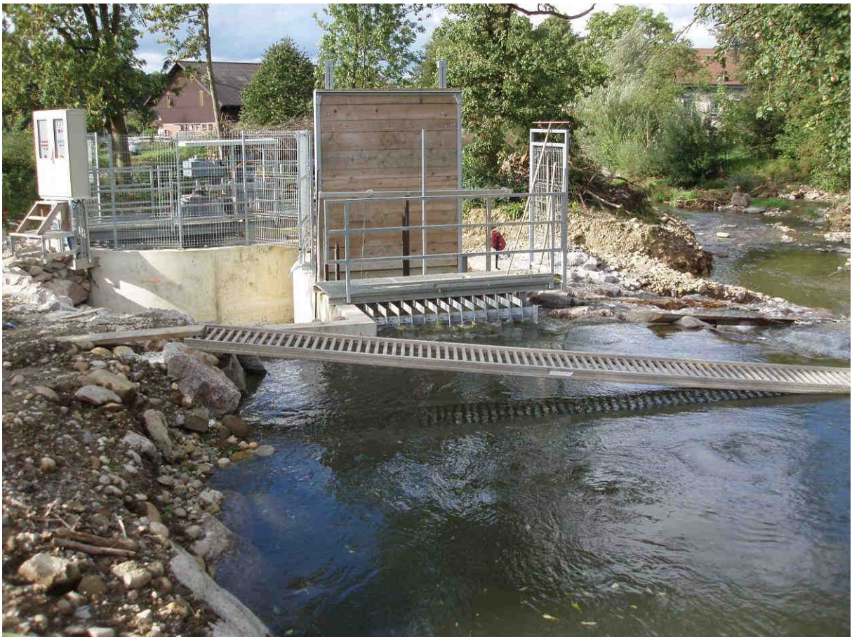
Fig. 5: Ansicht des Wasserwirbelkraftwerks Schöffland vom Oberwasserkanal her gesehen
