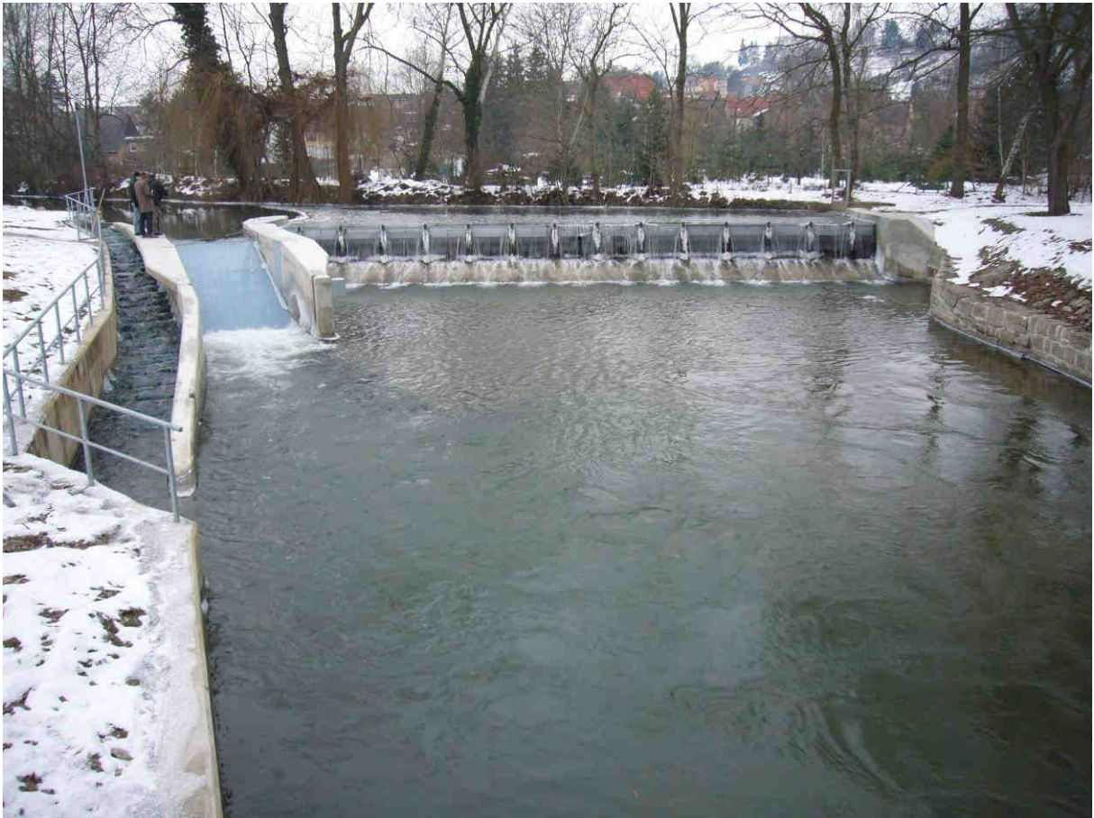
Fig. 36: Übersicht über die Anlage Sophienwehr in D-Bad Sulza
