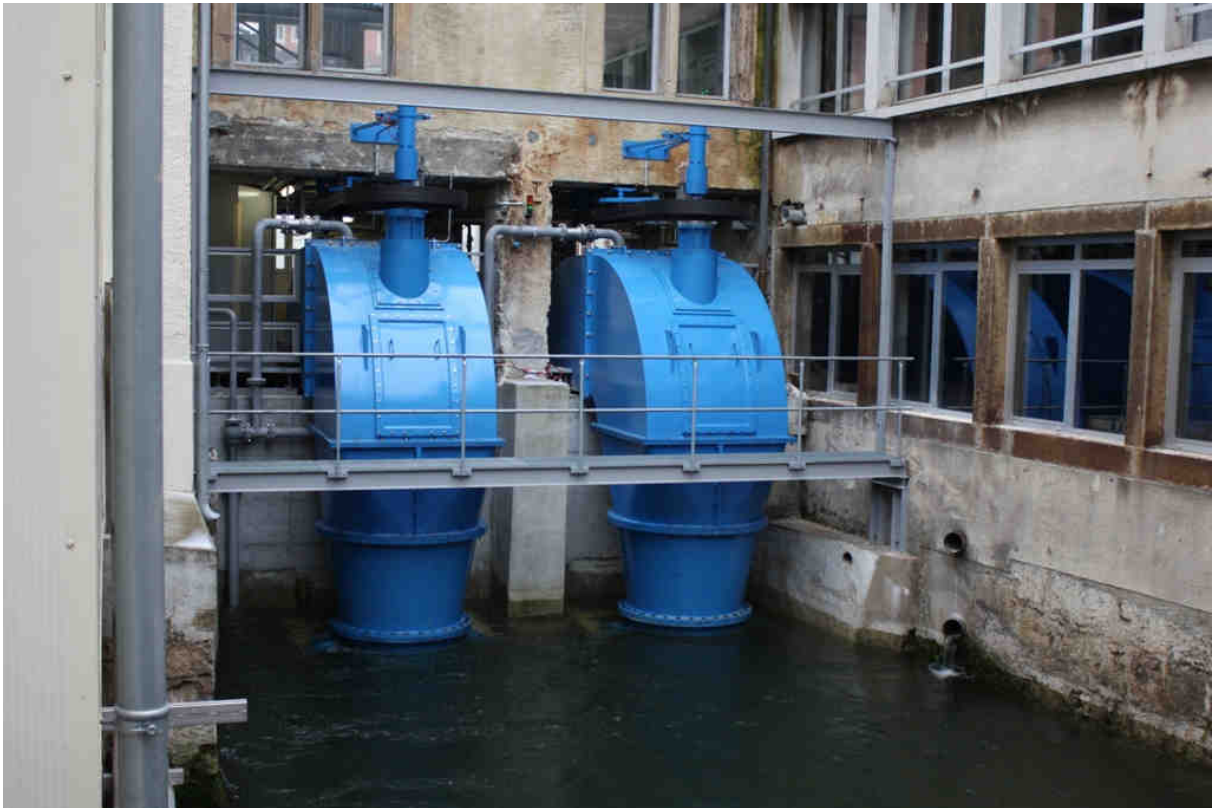
Fig. 45: Heberturbinen in der Anlage UMV in Vallorbe an der Orbe
