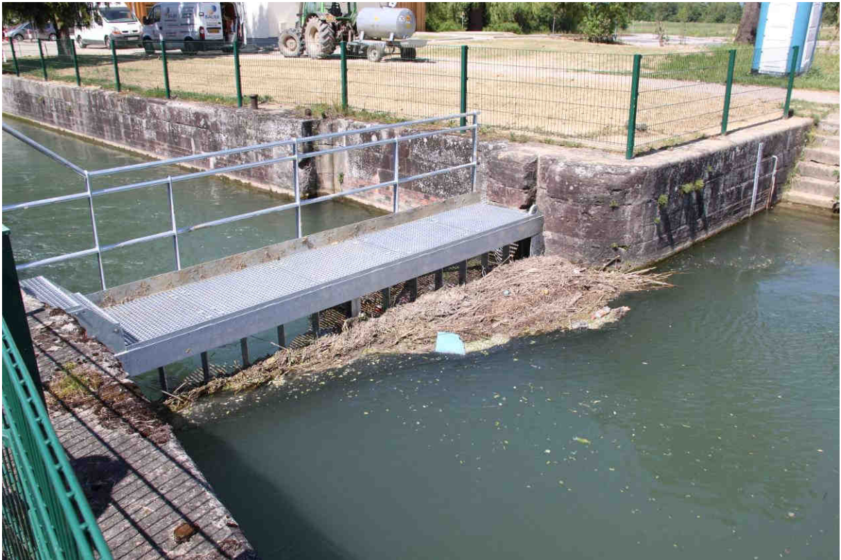
Fig. 33: Zusätzlicher Grobrechen an den VLH-Anlagen in Huningue, der aber rasch verstopft und zu einem zusätzlichen Betriebsaufwand führt.
