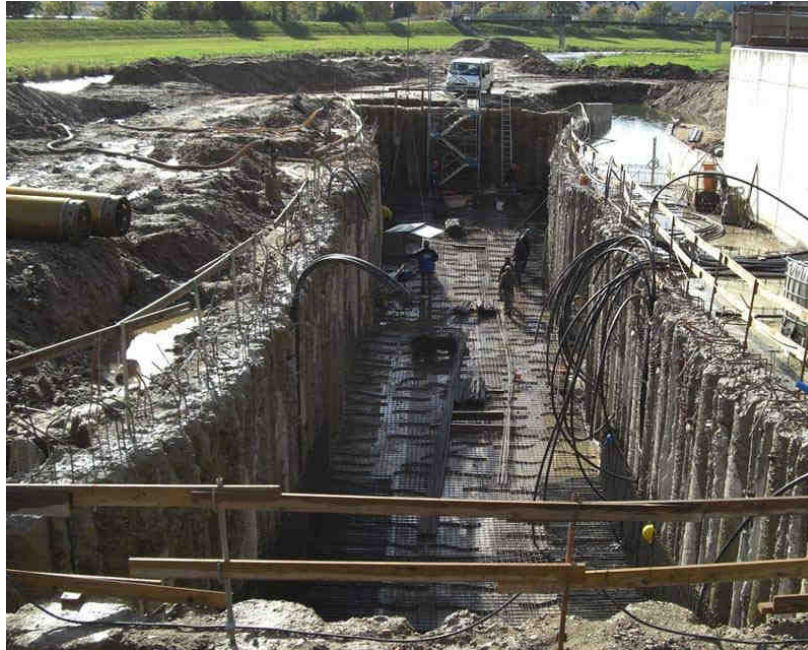
Fig. 39: Anlage Gengenbach im Bau; rückverankerte Bohrpfehlwand (Quelle: Hydro-Energie Roth GmbH)
