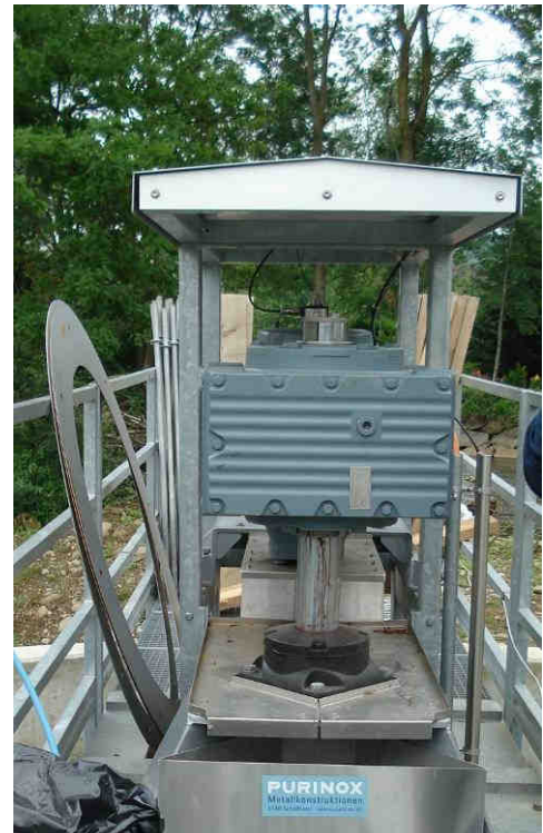
Fig. 6: Schutzdach über der Getriebe-Generator-Einheit des Wasserwirbelkraftwerks Schöffland
