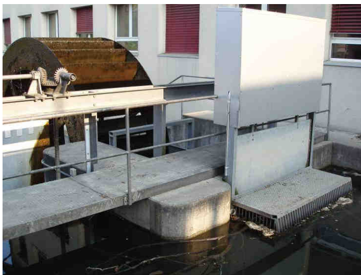
Fig. 20: Feinrechen und Einlaufschütze
