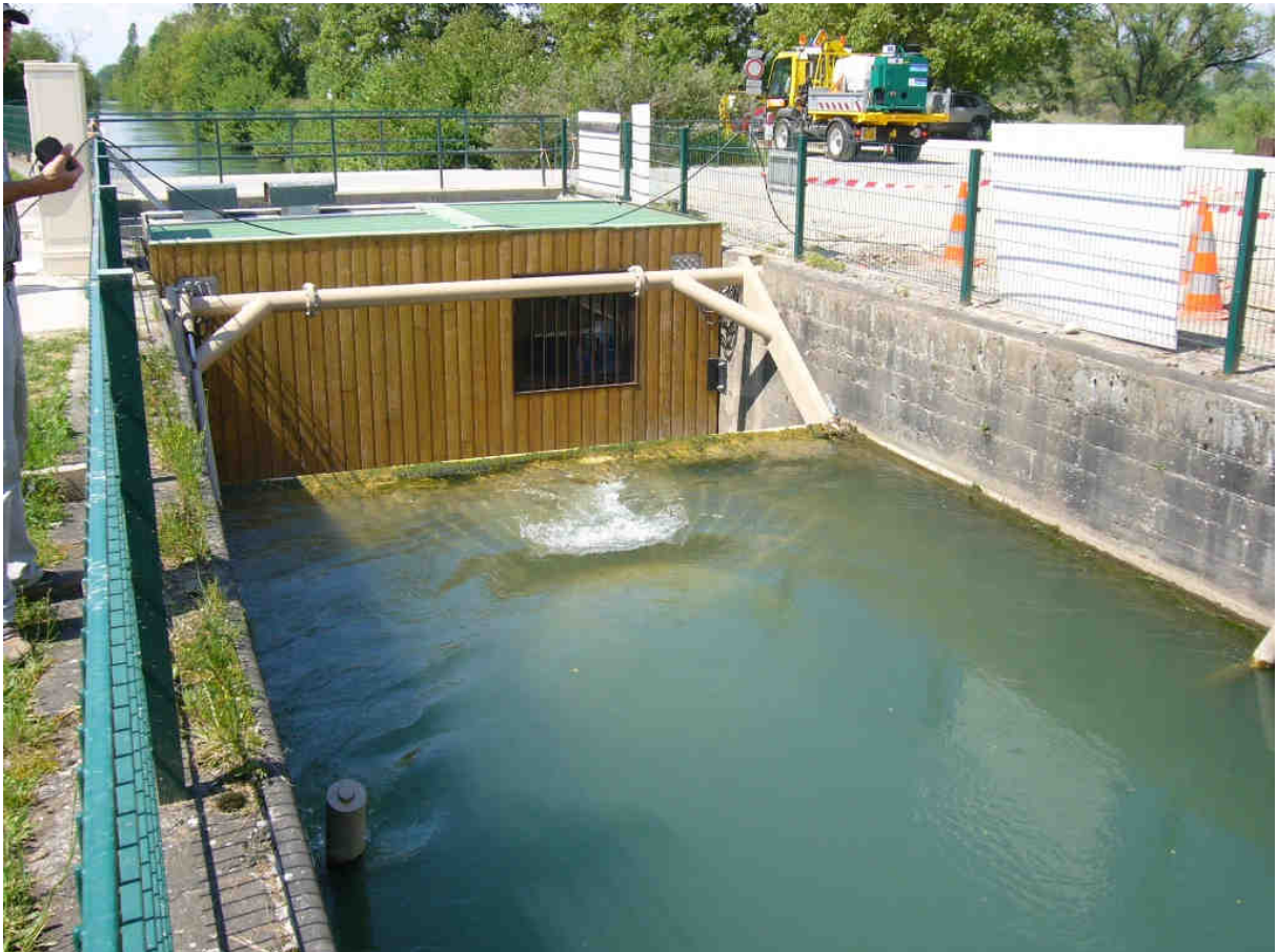
Fig. 30: Ansicht des VLH-Konzepts an der Schleuse Nr. 2, Huningue vom Oberwasser her. Von der gesamten Anlage ist nur der Schwenkarm der Maschine (weiss) sowie der Container (braun) mit den Nebenanlagen und Hilfsbetrieben sichtbar (hier direkt über dem Unterwasser und damit unter der Geländeoberfläche aufgestellt, da im Kanal kein Hochwasser zu befürchten ist).
