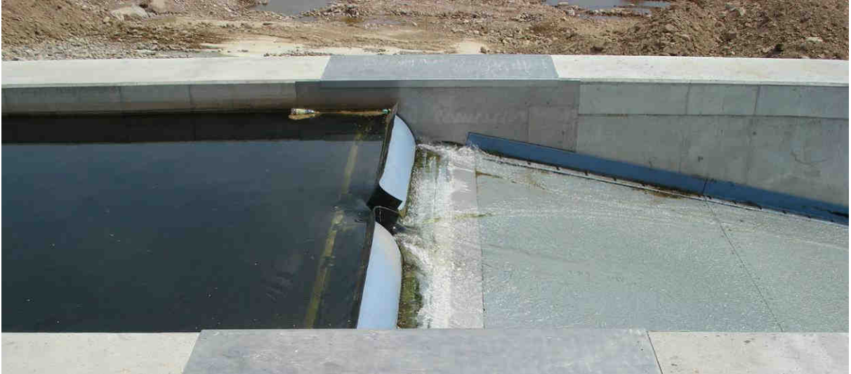
Fig. 38: Fischabstiegsmöglichkeit durch eine permanente Öffnung zwischen den Geschwemmselklappen an der Anlage Gengenbach
