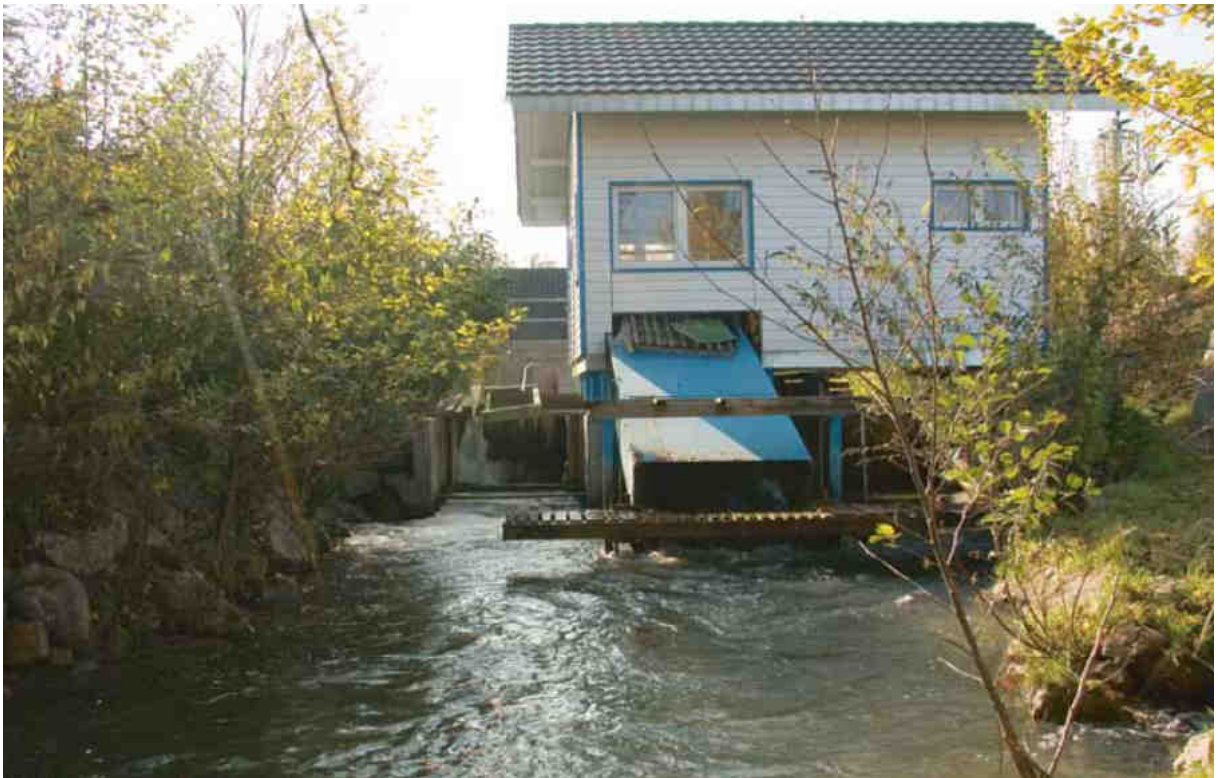
Fig. 26: Wasserkraftschnecke „Alte Ziegelei“, Derendingen (Quelle: Faktor Verlag AG)
