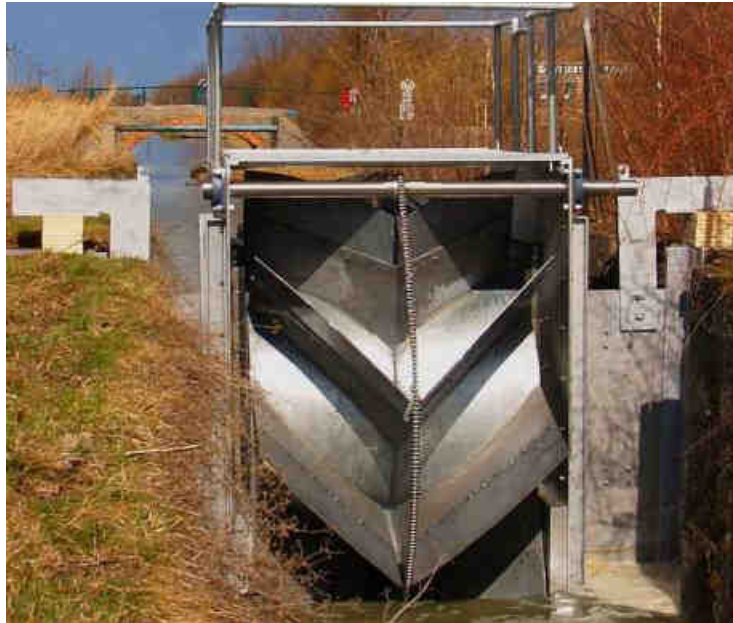
Fig. 12: Staudruckmaschine, Pilotanlage am Wiener Neustädter Kanal (Quelle: WICON Generatoren)
