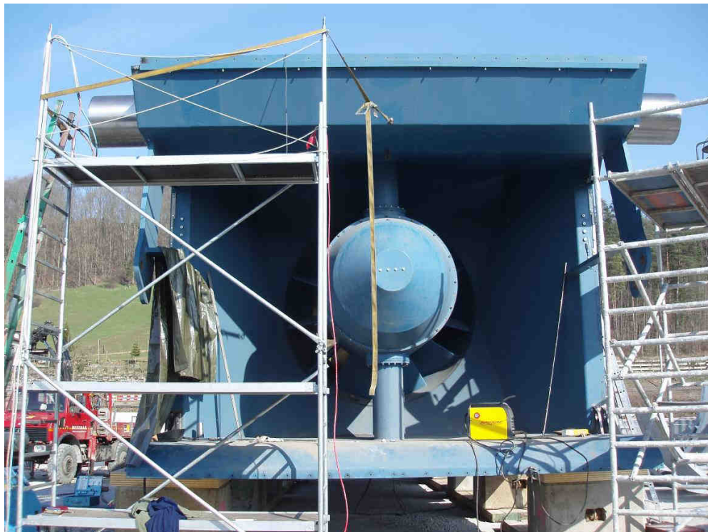
Fig. 41: Turbineneinlauf mit Bulb des beweglichen Kraftwerksgehäuses an der Anlage Kradolf-Schönenberg vor der Montage in den Trog
