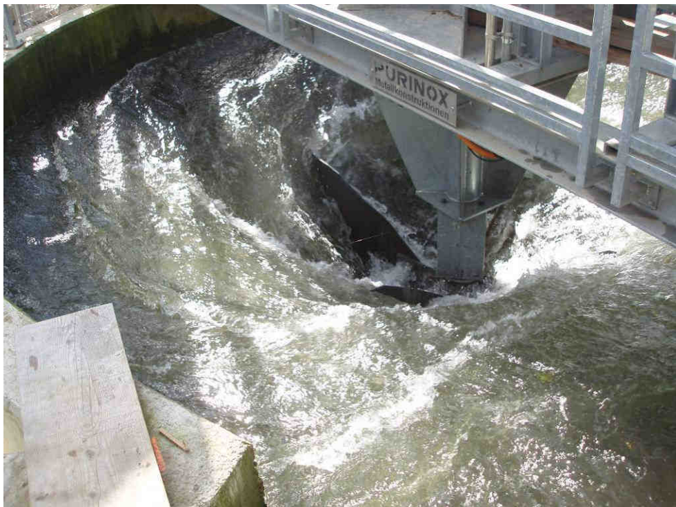
Fig. 8: Rotor des Wasserwirbelkraftwerks Schöffland im Betrieb
