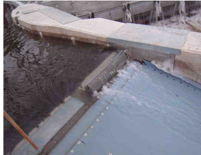
Fig. 40: Anlage Bad Sulza mit Rechenreinigungsbalken links und den Geschwemmselklappen rechts (wobei nur eine nach dem Reinigungszyklus wieder in Normalstellung zurückgefahren ist, die rechtsufrige klemmt)
