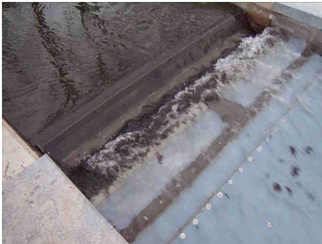
Fig. 40: Anlage Bad Sulza mit Rechenreinigungsbalken links und den Geschwemmselklappen rechts (wobei nur eine nach dem Reinigungszyklus wieder in Normalstellung zurückgefahren ist, die rechtsufrige klemmt)
